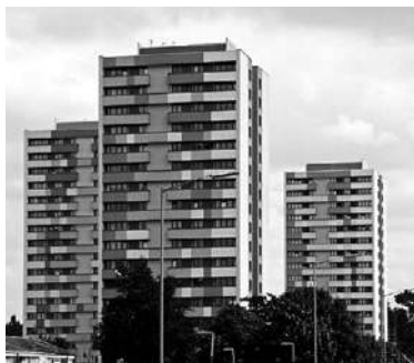
block of flats многоквартирный дом
